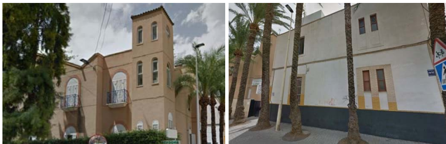
Imagen 2. Fachada mortero monocapa
