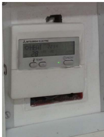
Imagen 15. Temperatura de consigna de 28°C en el bloque viejo
